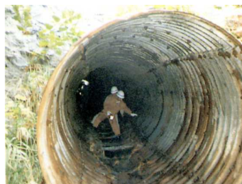
コルゲート管内へのサーモコン充填。
