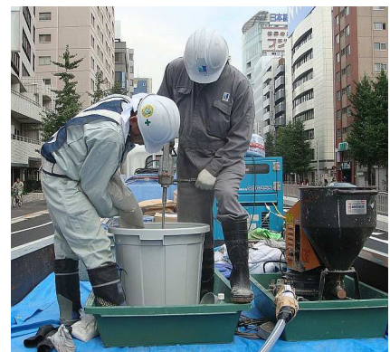
ハンドミキサーによる施工
