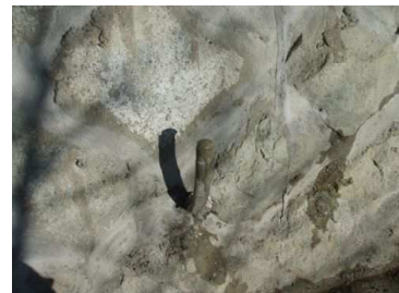
サーモコンが確認管まで体積膨張し、充填完了。
