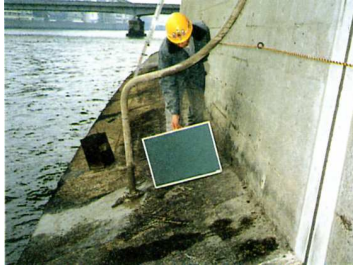
護岸コンクリートを削孔し、水中で発泡・硬化する水中サーモコンを打設します。
