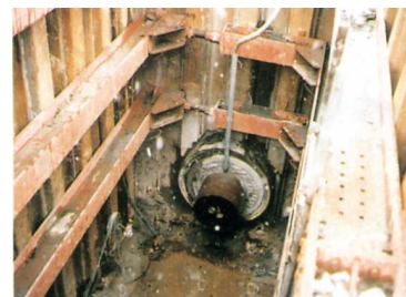
上下水道管内へのサーモコン充填。
