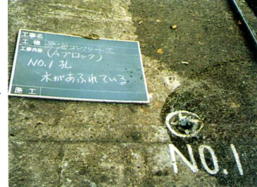
打設した水中サーモコンの体積膨張に伴い、削孔部から滞留水が溢れ出てきます。
