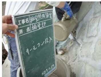
目地に挿入した注入管からサーモコンを流し込みます。
