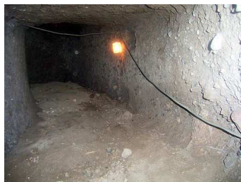
特殊地下壕・廃坑の充填
