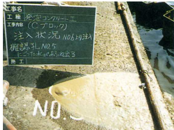
空隙部の滞留水がすべて排出され、充填完了。
